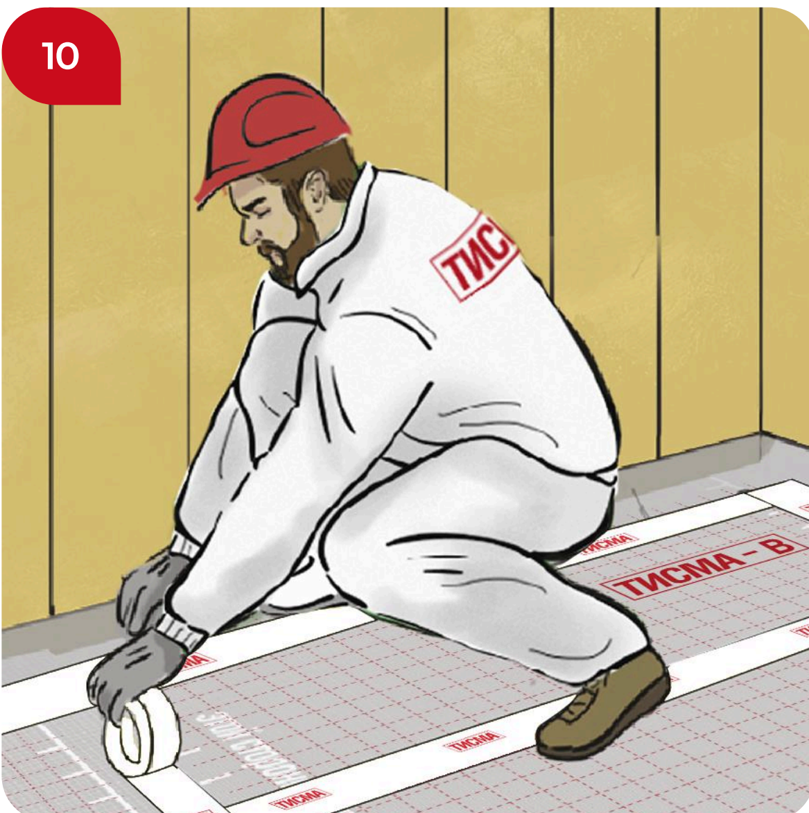
10 Стыки и места крепления пленки проклеиваем лентой ТИСМА для проклейки швов. Пароизоляция, уложенная на стене, должна быть проклеена с пароизоляцией, раскатанной на полу, для создания герметичного контура.
