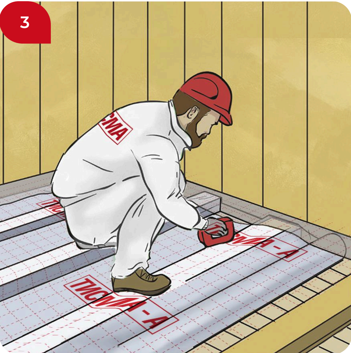
3 Раскатываем ветро-гидрозащитную мембрану ТИСМА поперек балок и фиксируем к балкам степлером.
