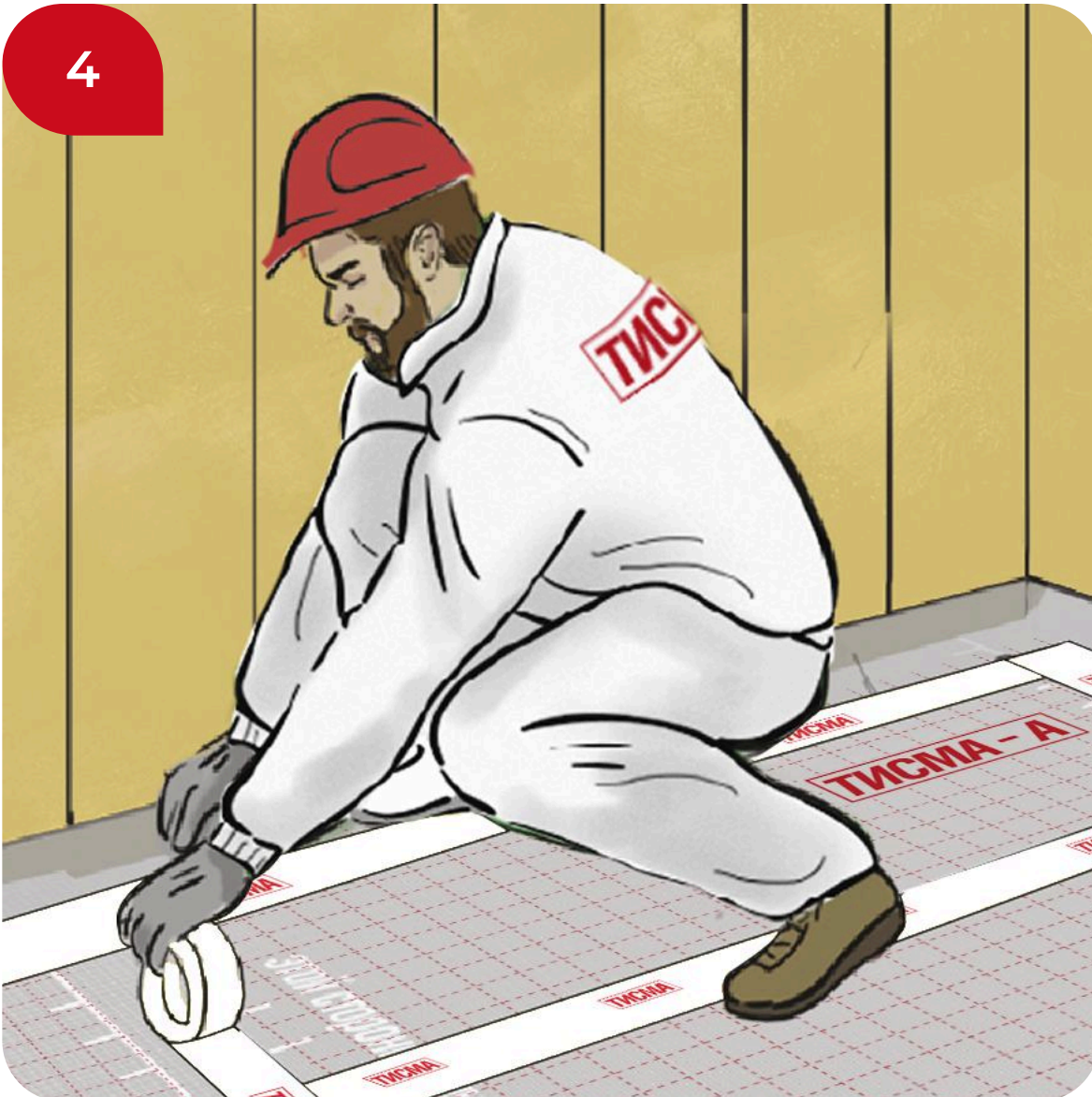
4 Стыки и места крепления мембраны проклеиваем лентой ТИСМА для проклейки швов.
